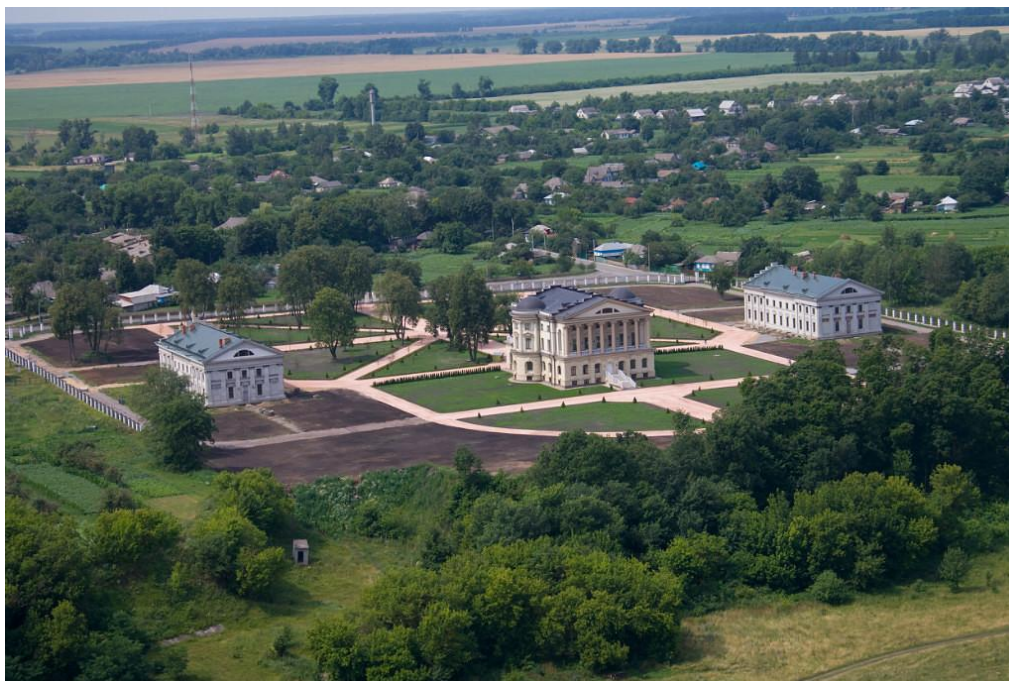
Рис. 2. Дворцово-парковый комплекс К. Разумовского (Тепловка). Батурин. 2013 г.
