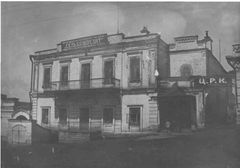
Рис. 9. Дом по ул. Ленина, 9. Фото М.И. Глазыриной, 1938 г. Архив Т.М. Бочкарёвой
